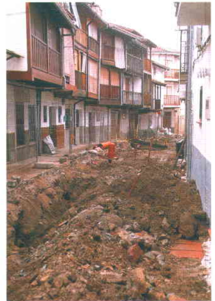
Obras de rehabilitación de la Calle del Moral, en la antigua Judería.
